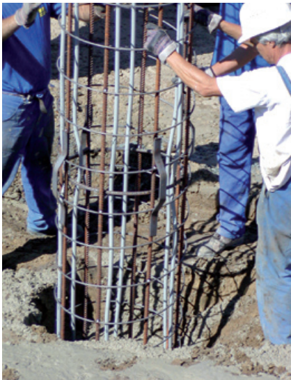
Energiacölöp telepítése. 163 darabot helyeztek el a földben
