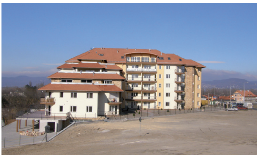
Mediterrán stílusú ház. Energiacölöpök és hőszivattyúk segítségével a föld kérgéből nyerik ki a lakásokat fűtő energiát
